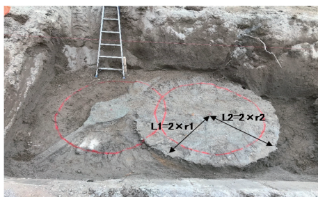
図 7 改良体天端面
