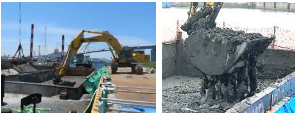
写真-2 カルシアバケットの使用状況
