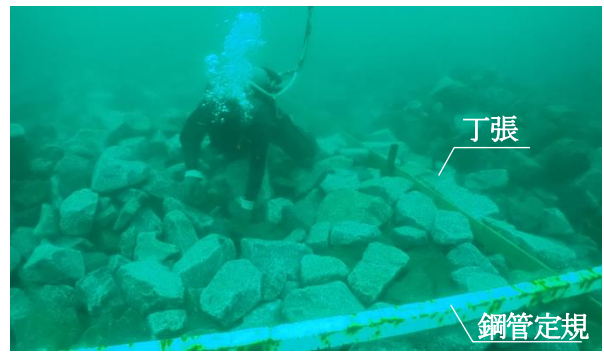
写真-1 潜水士による捨石マウンド築造
