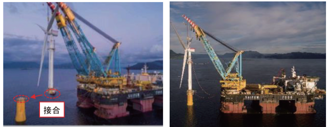
写真-1 スパー型浮体式洋上風車の施工
