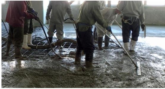
写真-3 土間コンクリートの打込み状況
