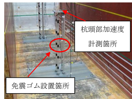
写真-1 杭基礎設置状況
