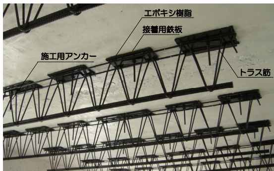
写真-3 工法2補強部材設置状況
