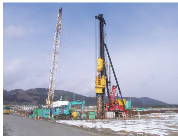
図-2 現地試験状況(先行削孔)
