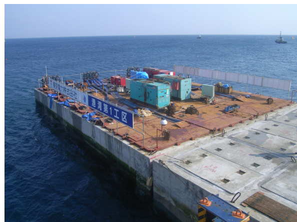
図-2 ケーソン据付状況(着底完了)
