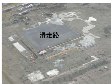
写真-1 実験後ヤード全景 1)
