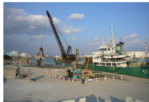
写真-2 既設岸壁への適用状況
