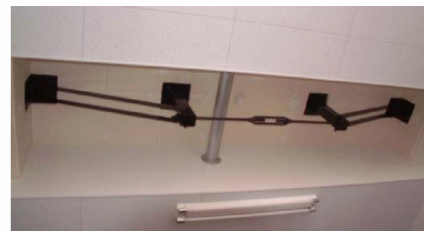
補強部材取り付け状況
