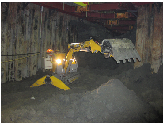
無人掘削状況
