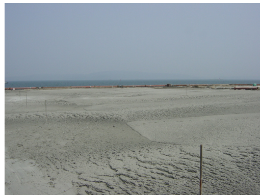
固化版(本施工完了後)
