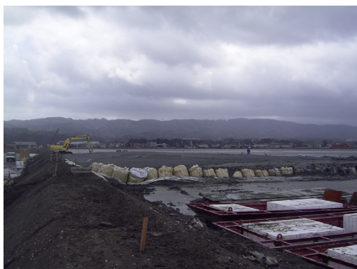
試験施工完了
