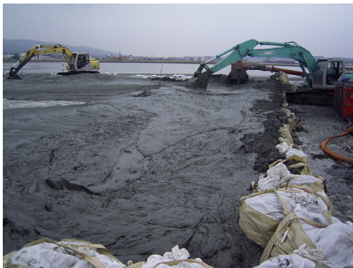
試験施工状況
