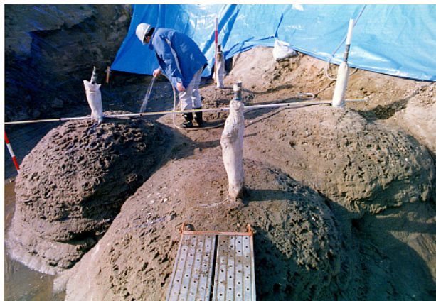
掘り出された改良体の形状
