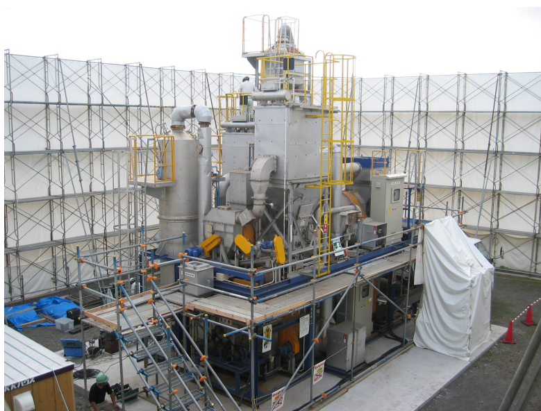
可搬式ダイオキシン類無害化プラント
