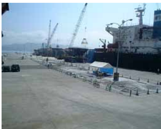
施工状況写真
