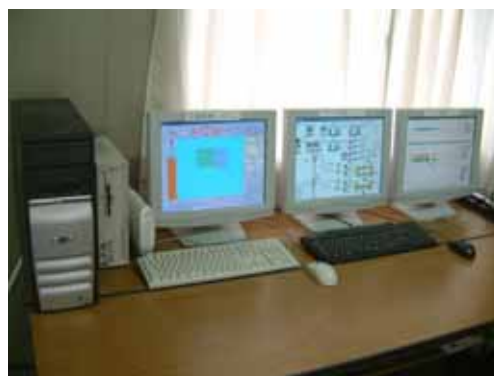
プラント監視システム
