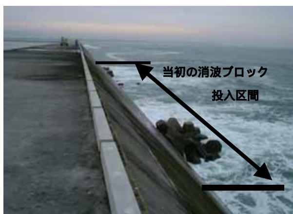
N5 区間変形状況
