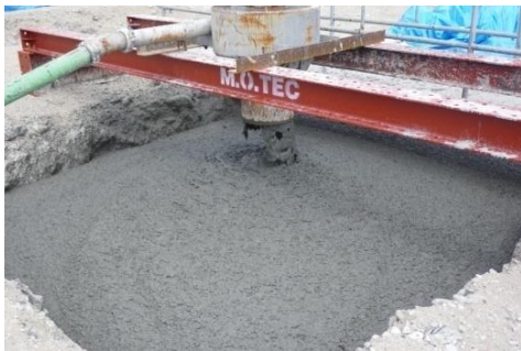
写真-1 打設状況 (気中)
