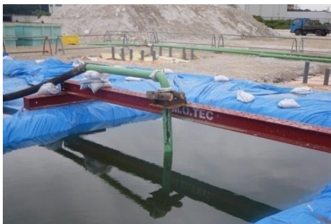
写真-2 打設状況 (水中)
