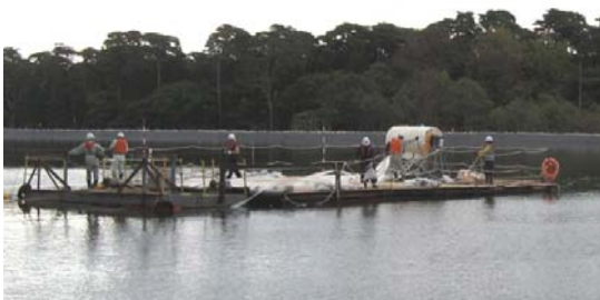
写真4 中段PBDの敷設状況
