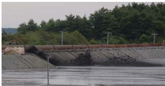
写真3 浚渫土の処分状況
