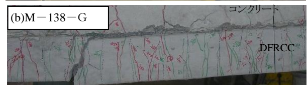
写真-3 複数微細ひび割れ性状の一例
