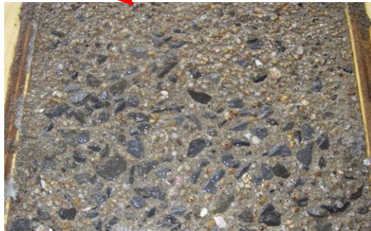
写真-1 打継目処理の一例
