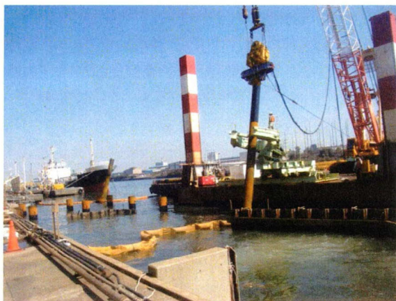
写真2 杭打打設状況(パイプロハンマ使用)
