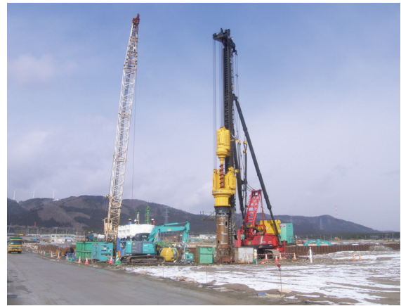
図一七. 1 現地試験状況(先行削孔)
