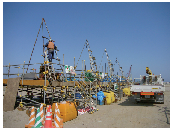
図一七. 2 コアサンプリング状況(ボーリング)
