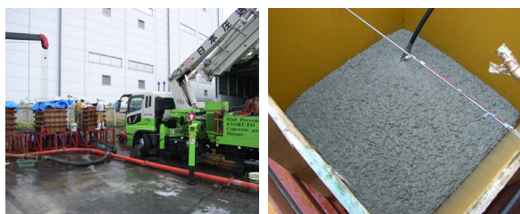
写真-1 圧送・圧入状況 (左: 圧送状況、右: 圧入状況)
