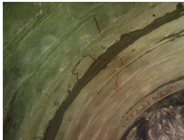
写真-2 吹付けコンクリートひび割れ状況
