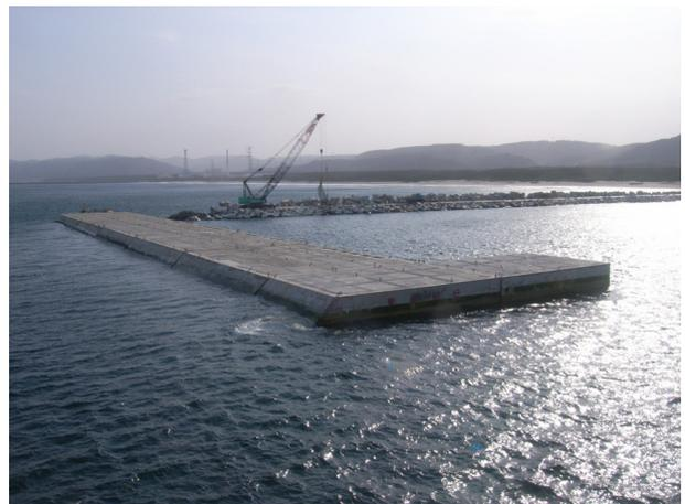
図-15 放水口護岸ケーソン据付完了全景
