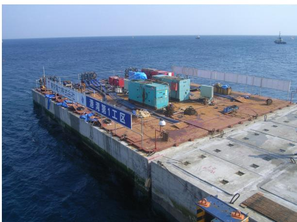
図-12.2 ケーソン据付状況(着底完了)
