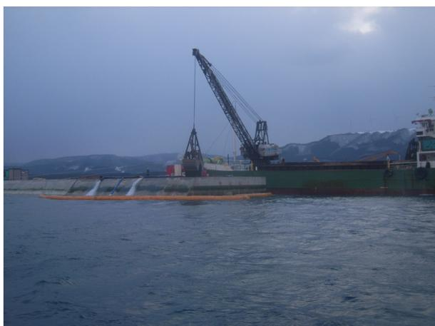
図-14 中詰材投入時の排水状況
