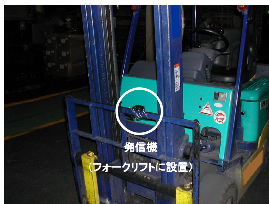
写真2 発信機 設置状況
