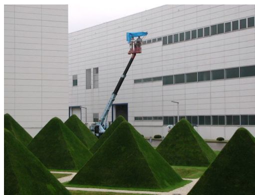
写真-6 3D レーザスキャナー設置(高所作業車 10m)
