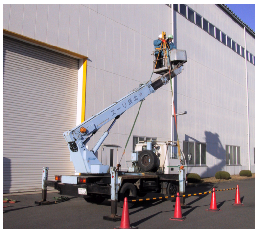
写真-7 ノンプリズムレーザ式 TS 設置(高所作業車 10m)
