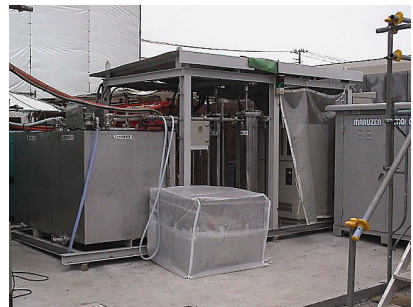
写真-7 促進酸化処理装置
