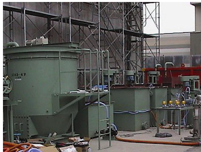
写真-5 凝集沈殿処理装置
