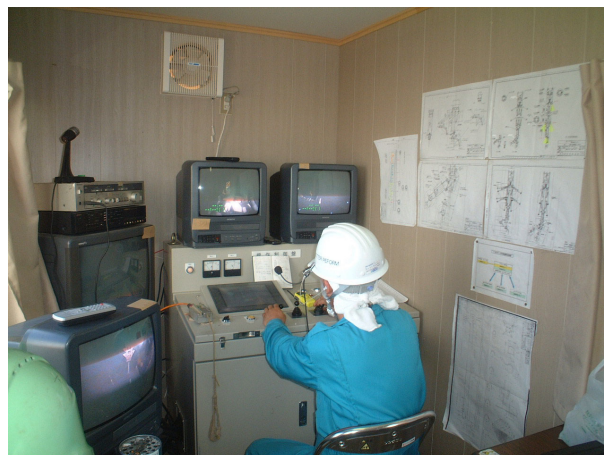
写真-4 施工状況(遠隔操作)
