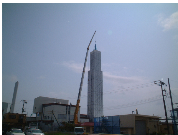
写真-3 施工状況(ロボット投入)
