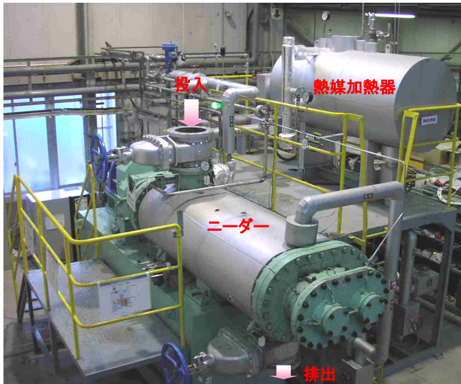
写真-4 実証プラント全景
