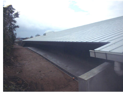
写真-6 施工状況
