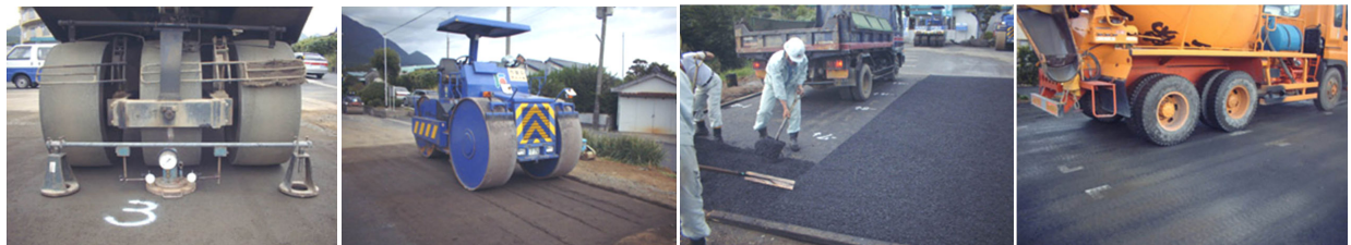
写真-8 施工状況
