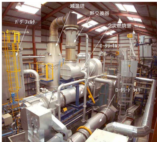
写真-2 実証施設
