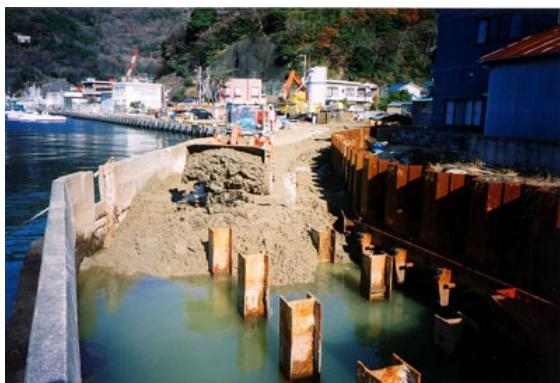
写真-2 処理土の打設状況
