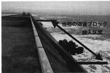
写真-1 N5区間変形状況
