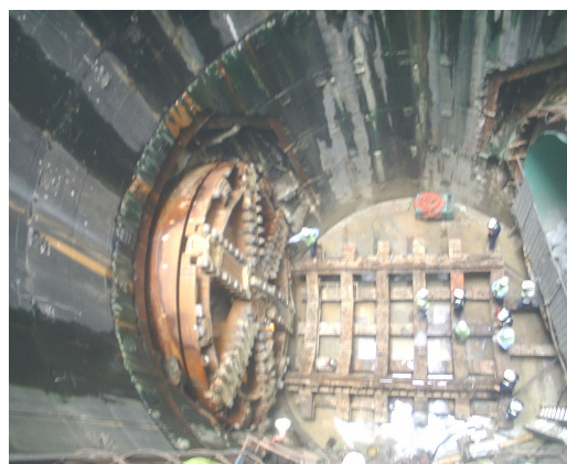
写真-8 シールド到達完了
