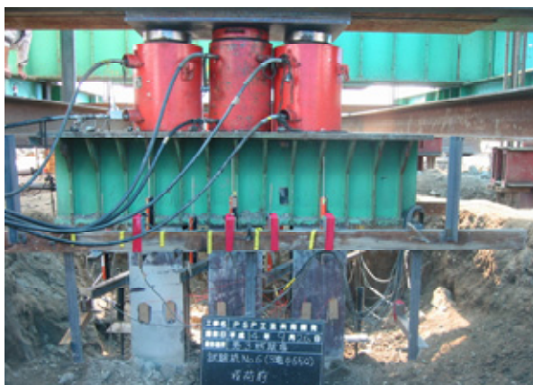
写真 - 1 載荷試験状況(No.6)
