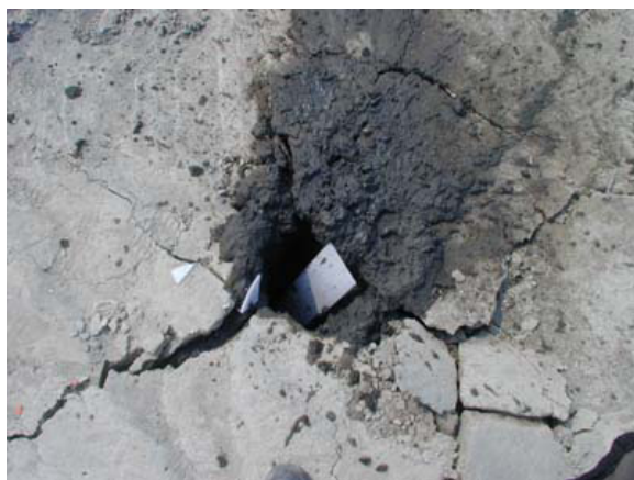
写真 - 8 打設完了状況 [固化地盤]
