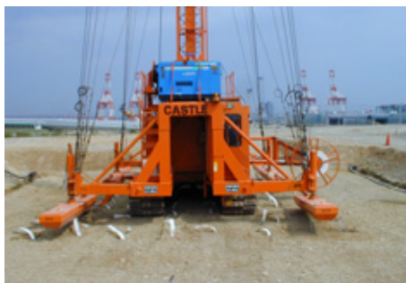
写真 - 10 ドレーン打設状況[実証実験2]
