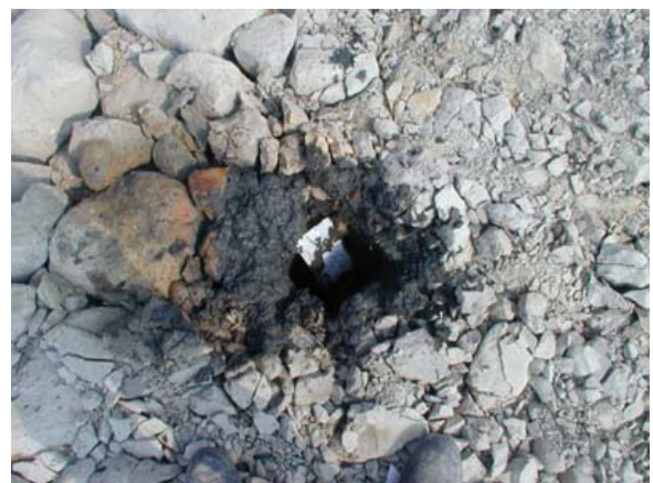
写真 - 9 打設完了状況 [泥岩密詰め粘土地盤]
