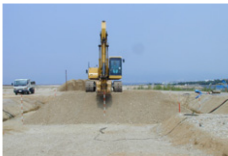
写真 - 11 盛土載荷(2m)完了[実証実験2]
