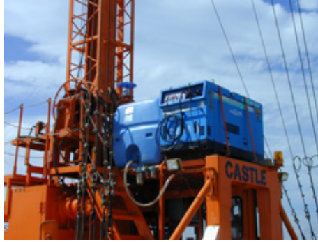
写真 - 4 空圧供給設備
