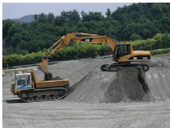
写真 - 5 掘削・積込み性能試験状況
