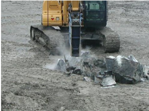
写真 - 8 転石破碎性能試験状況
