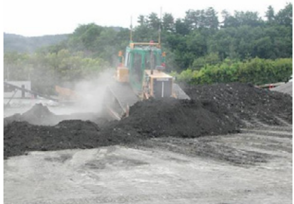
写真 - 7 敷均し性能試験状況
