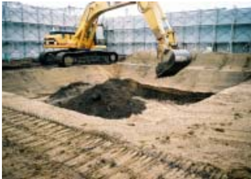
写真 - 3 微生物混入土の埋戻し
