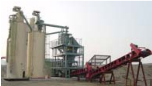
写真 - 5 システムの全景 (1.0m³級プラント)
