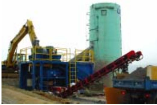
写真 - 4 システムの全景 (0.2m³級プラント)
