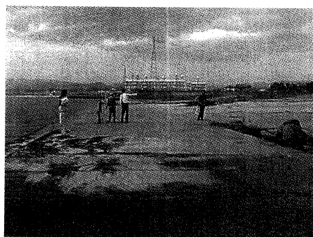
図-7 仕切堤に打ち上げられた砂
