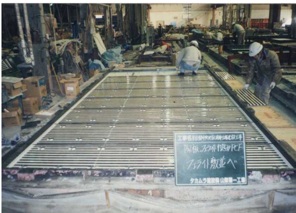
写真 - 2 フェライトタイトル敷き込み状況
