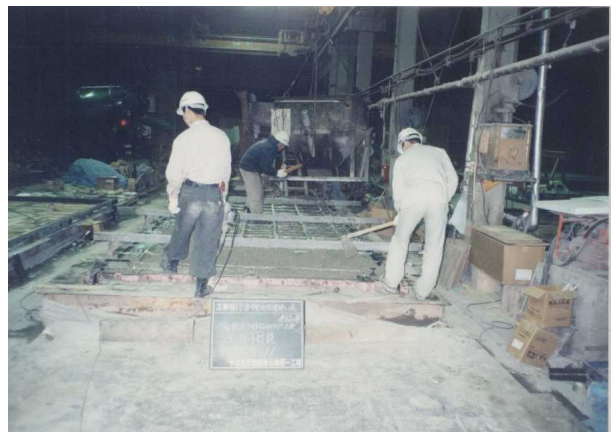
写真 - 5 コンクリート打設状況
