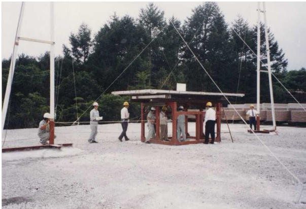
写真 - 6 アンテナ間の位置確認状況
