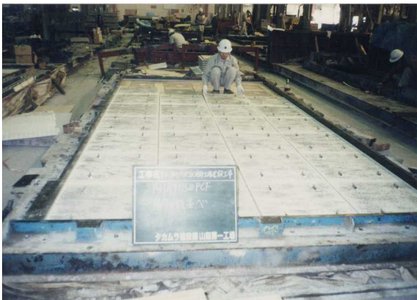
写真 - 1 大型タイトル敷き込み状況
