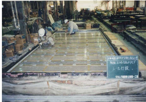
写真 - 3 フェライトタイトルの防水処理
