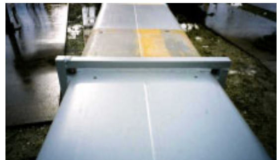
写真 - 2 BタイプCFT柱接合部
