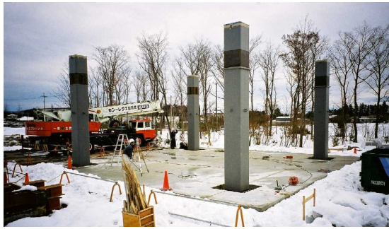
写真 - 3 建方状況
