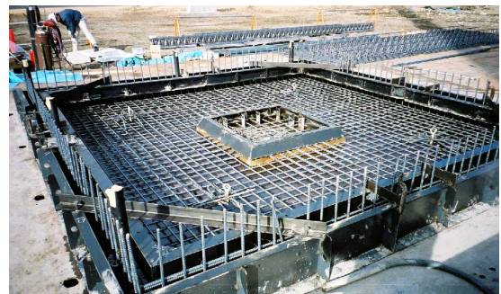
写真 - 5 Bタイプキャピタル製作状況
