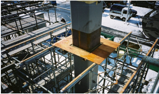
写真 - 10 型枠取付状況
