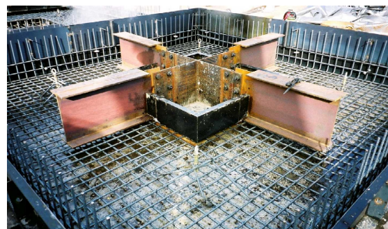
写真 - 4 Aタイプキャピタル製作状況
