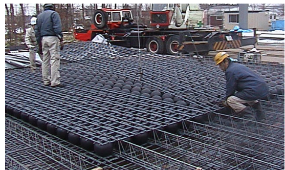
写真 - 6 大型ハーフP C a 製作状況
