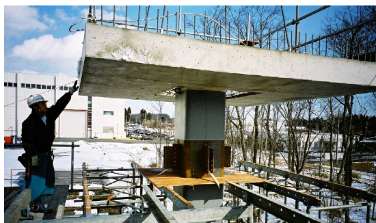
写真-7 Aタイプキャピタル建方状況
