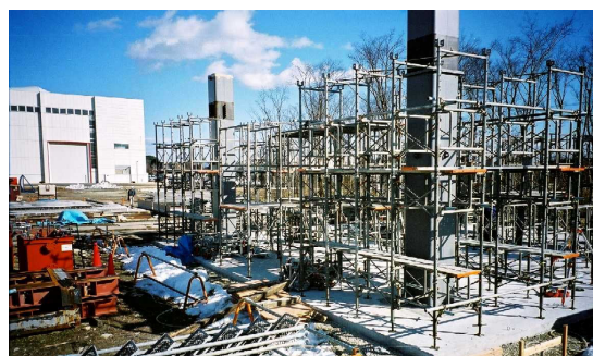
写真-9 支保工組立状況
