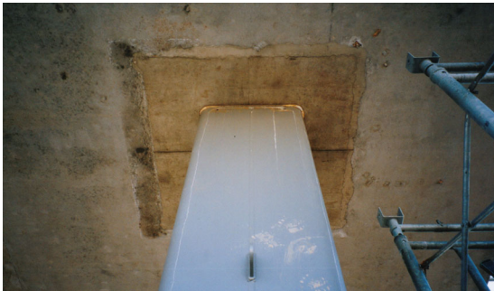
写真 - 11 接合部コンクリート仕上がり状況
