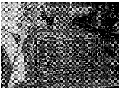
写真-2 コンクリート打設状況
