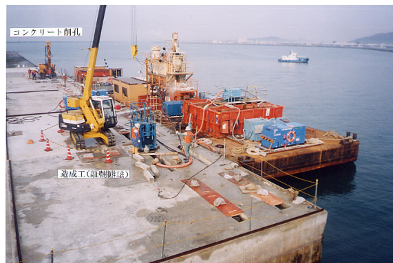
写真 - 2 沖防波堤における施工状況
