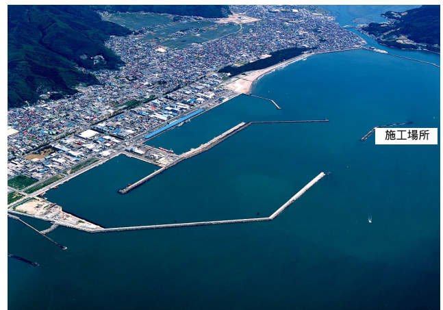
写真 - 1 沖防波堤における施工状況
