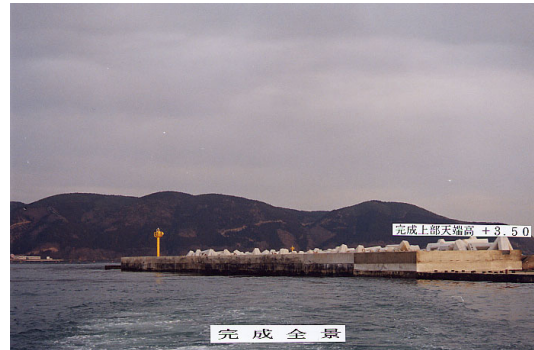
写真 - 5 施工完了後の堤体全景
