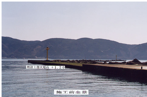
写真 - 4 施工前の堤体全体
