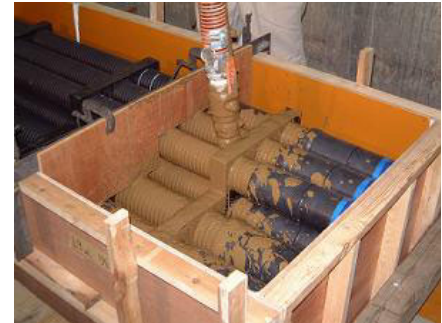
写真 - 1 流動化処理土打設状況
