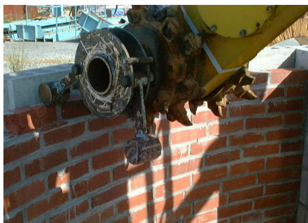
写真 - 3 レンガ解体実験状況
