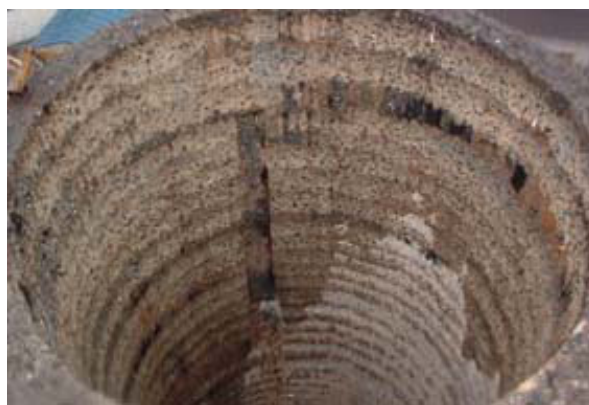
写真 - 6 内部切削状況
