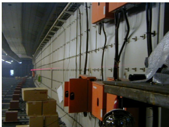
写真 - 4 レーザとCCDカメラによる計測状況写真
