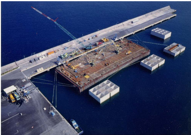
写真 - 1 浮遊状態における高流動コン打設状況
