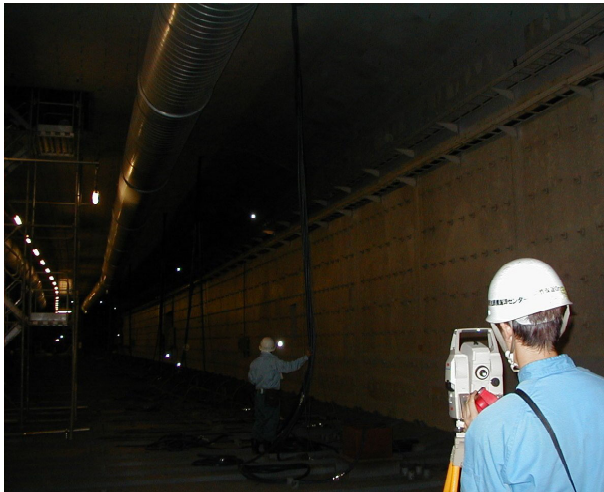
写真 - 3 トータルステーションによる3次元計測状況
