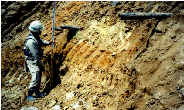
写真 - 2 曲がり鋼管先端部測量状況
