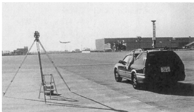
写真一 1 東京国際空港での測量の状況
